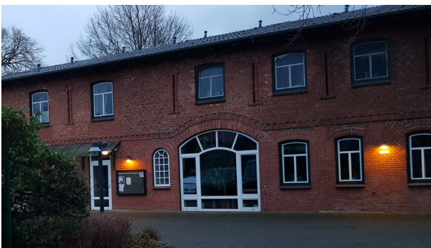
Bsp. Dorfhaus mit Feuerwehrgerätehaus
